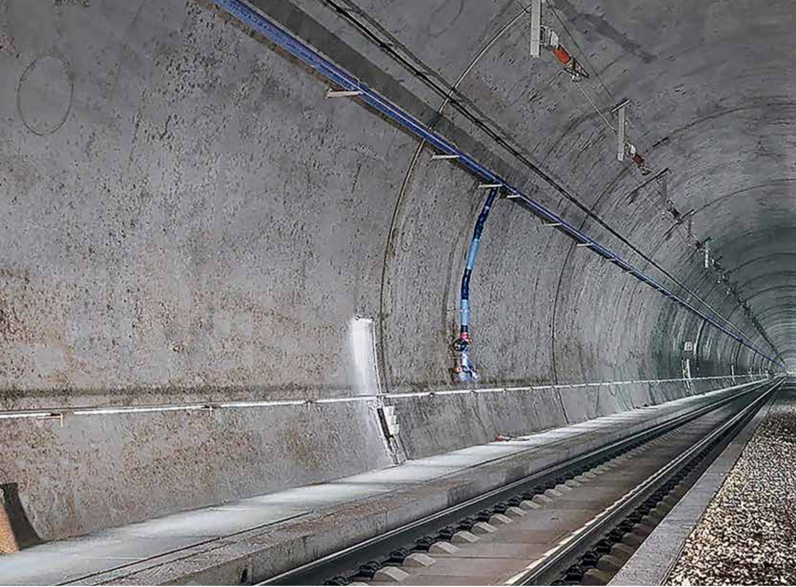
Lainzertunnel Wien, Österreich
