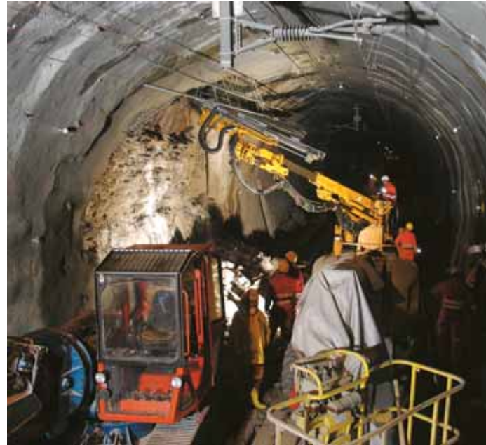
Löschwasserleitung | Fire-water piping
