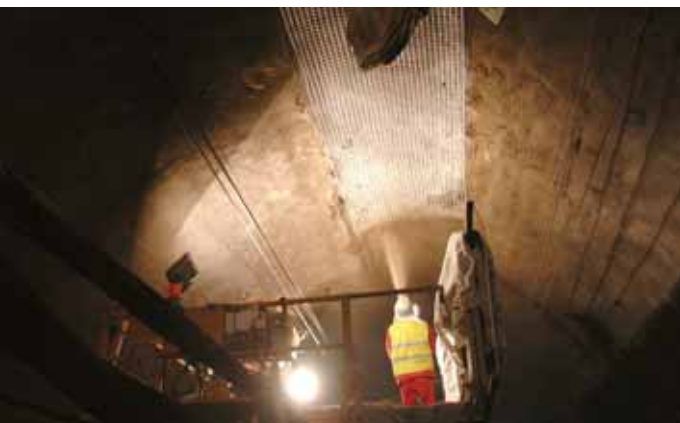
Spritzbetonauftrag | Shotcrete spraying
